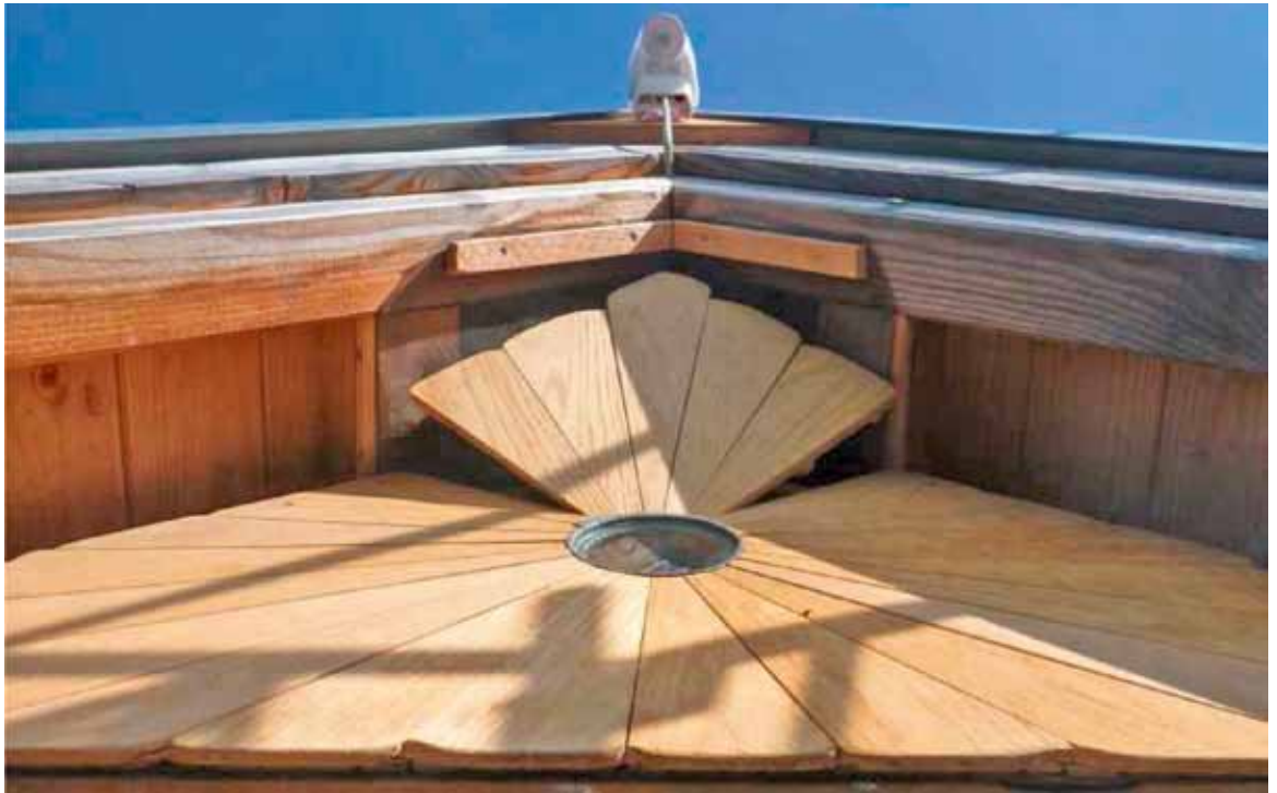
Bypass-Klappe für die Sommerlüftung. Bild: Rolf Canters
